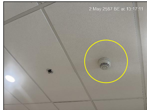
ภาพที่ 15 เครื่องตรวจจับควัน/เครื่องตรวจจับความร้อน
