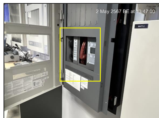
ภาพที่ 18 อุปกรณ์แจ้งเหตุกรณีเกิดเหตุฉุกเฉิน
